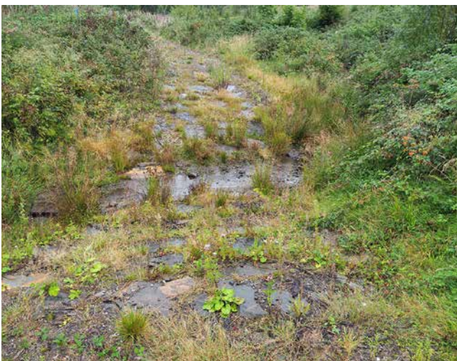
Abb. 25: Furt mit großen gesetzten Wasserbausteinen. Auf Rückewegen ist die Herstellung einer steileren Zuwegung möglich. (Foto: J. Wellhäuser)
