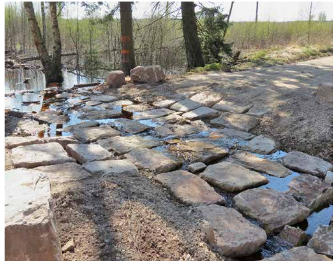
Abb. 26: Bei der Herstellung einer gesetzten Furt ist auf ausreichend breite Fugen zu achten. Diese können mit feinerem Substrat verfüllt werden. (Foto: M. Schmidt)
