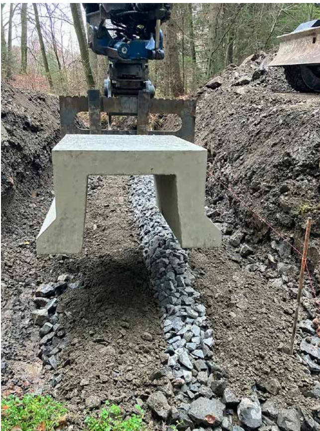
Abb. 18: Ein Haubenprofilelement wird mit einem Gabelträger über das vorgeformte Bachbett gesetzt. Der gesamte Durchlass besteht aus mehreren hintereinander gesetzt und miteinander verschraubten Elementen.
