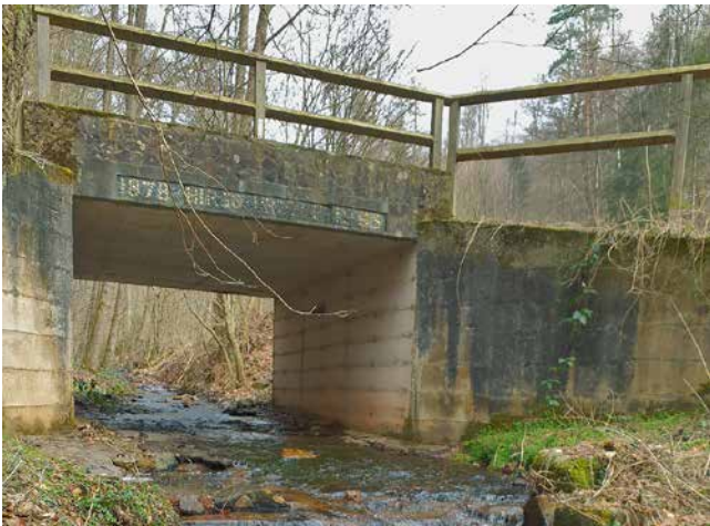
Abb. 13: Brücken verengen den Fließgewässerquerschnitt kaum und beeinträchtigen die Durchgängigkeit bei natürlicher Sohlanlage nur wenig. Trockene Seitenstreifen ermöglichen auch Landtieren die Passage durch das Bauwerk. (Foto: M. Schmidt)
