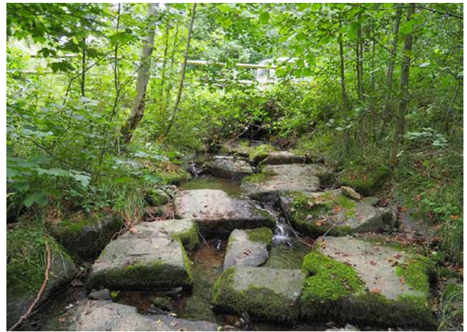
Abb. 29: Eine aus großen Wasserbausteinen gesetzte Blockrampe. Die Durchgängigkeit der Rampe könnte durch etwas breitere Fugen (20–30 cm) und die Einbringung von feinem Substrat in den Fugenbereichen weiter erhöht werden. (Foto: J. Wellhäuser)
