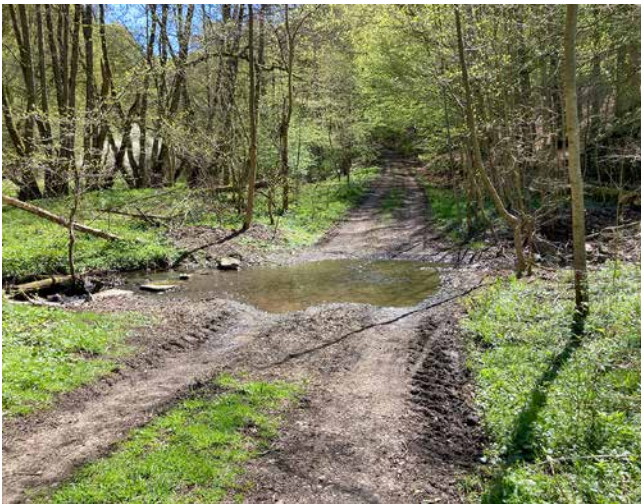
Abb. 24: Furt mit Schüttung aus 15–25 cm Wasserbausteinen, gemischt mit 0–56 mm Schotter. Linkerhand wurden Trittsteine eingebaut 27 . (Foto: C. Morkel)
