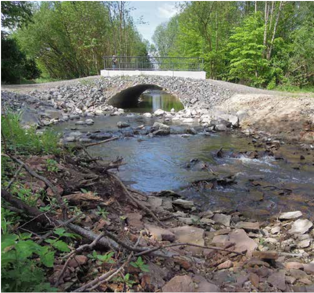
Abb. 17: Wellstahldurchlass als Haubenprofil auf Streifenfundamenten. Auch sehr große Spannweiten sind in dieser Bauweise realisierbar.
