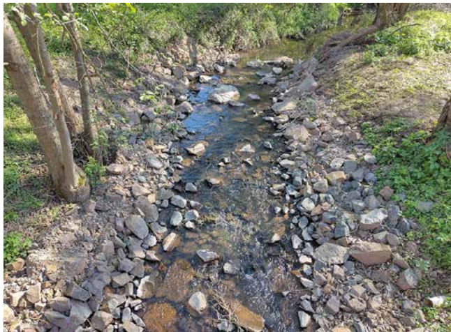
Abb. 28: Geschüttete Blockrampe unterhalb eines Durchlasses. Unmittelbar unterhalb des Durchlasses (an die untere Bildkante anschließend) wurde eine Grundschwelle aus größeren Steinen lückig in die Sohle eingebaut. Diese ragen etwa 10–15 cm über die Sohle des Durchlasses hinaus; weitere Grundswellen liegen im Abstand von etwa 8–10 m bachabwärts. Für Grundswellen eignen sich Steine der Größe LMB 40/200 oder LMB 60/300, bei kleinen Gewässern auch kleinere Steine. (Foto: W. Haaß)
