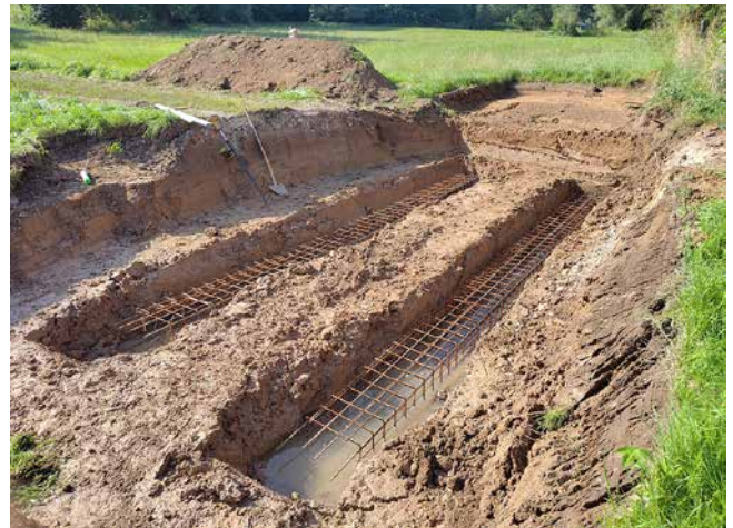
Abb. 15: Streifenfundamente für einen Haubenprofildurchlass im Bau. Bevor die Betonelemente darauf gesetzt werden, kann die Gewässersohle zwischen den Fundamenten modelliert werden 10 . (Foto: W. Haaß)
