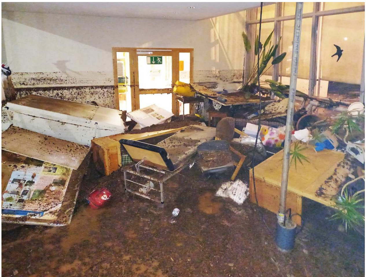
Foto 1: Überschwemmungsschäden im Gebäude der NW-FVA in Hann. Münden (Foto: Dr. Georg Leefken)
