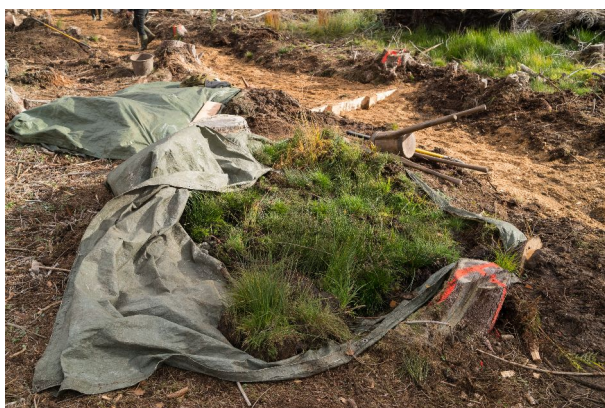
Abb. 17: Arbeitsschritte bei der Grabenverfüllung (von links nach rechts): Mischplatz für Holzhackschnitzel und Sägespäne (im Verhältnis 1:2), Verfüllen und Verdichten des Materials zwischen Spundwänden im gesäuberten Graben, sorgfältig abgelegte Vegetation zur anschließenden Wiederbepflanzung, verfüllter Grabenbeginn im Frühjahr 2023 (Fotos 1-3 Philipp Küchler, Foto 4 Maria Aljes)
