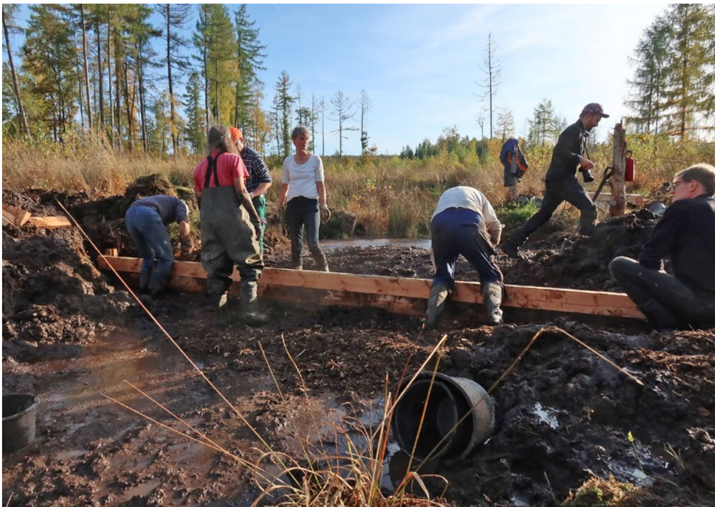
Abb. 3: Einbau einer Bohlenwand mit Freiwilligen während einer Projektwoche des Bergwaldprojekts e. V. in einem der breit verfallenen Gräben, die austretendes Quellwasser direkt am Austritt in den Lempegraben ableiteten (Foto: M. Aljes)
