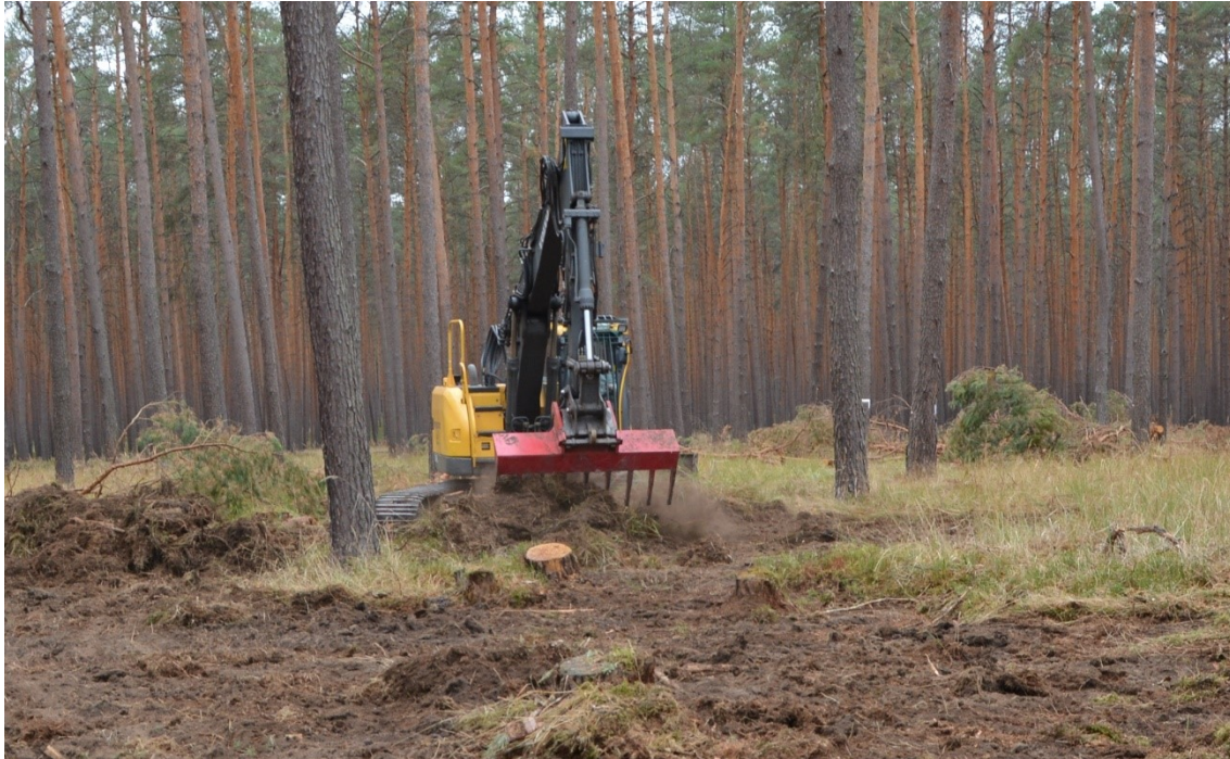
Abbildung 2: Flächenräumung mit dem Silvafix im Hohen Fläming.
